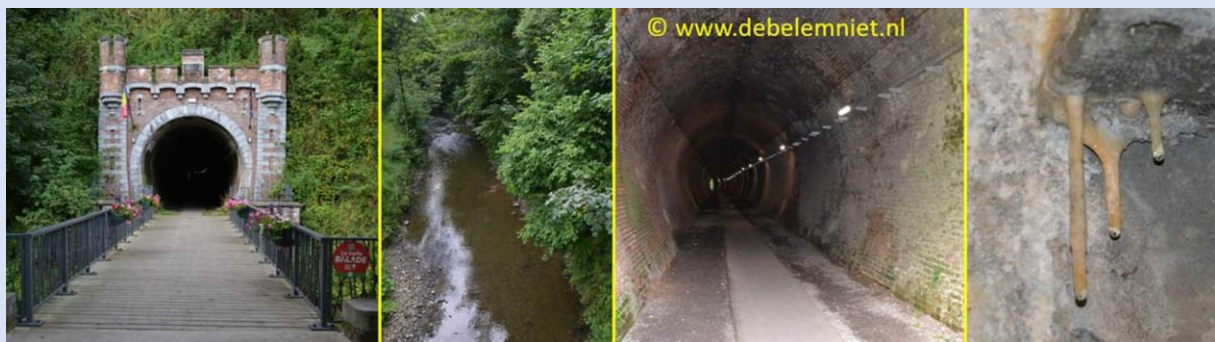
Afbeelding 23. Een bruggetje over de Berwinne voert naar de ingang van de tunnel. In de tunnel zien we druipstenen aan het plafond die gevormd zijn uit de kalk van het cement.
