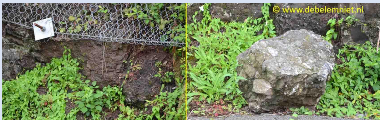
Afbeelding 34. Aan de onderkant van de rots – die met een staalgaasnet is ingepakt tegen vallend gesteente – kunnen we van de overkant van het spoor zien dat het om een conglomeraat gaat. De stenen er in zijn niet helemaal afgerond (en lijken nog wat op een breccie) dus de transportweg is niet zo lang geweest.
