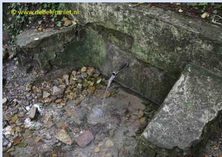
Afbeelding 29. Een bronnetje in het Waterwegske stroomt in een in beton gevatte metalen buis naar buiten.
