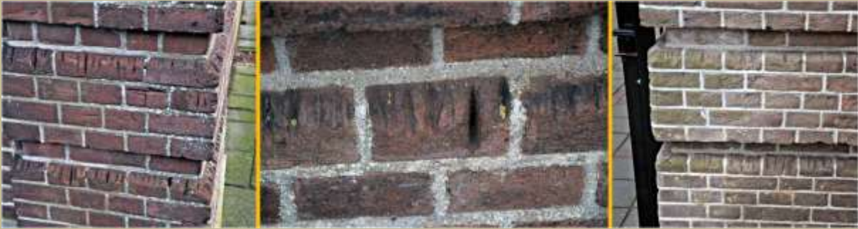
Een op krabsporen lijkend verschijnsel: slijpgleuven ontstaan door het slijpen van griffels
